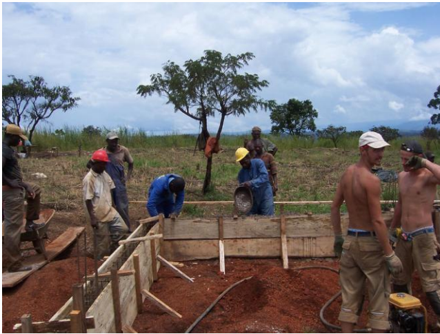
Bekisting van het gebouw
